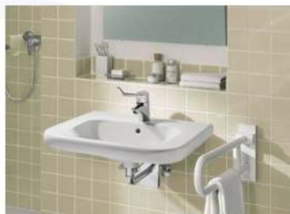
Bedienvorrichtungen im Waschtischbereich müssen gut zu erreichen sein. Einhebelmischbatterien (möglichst mit kontrastreichem, schwenkbarem Auslauf) sollten zum Standard gehören. (Siehe auch: „Armaturen im Bad“).
