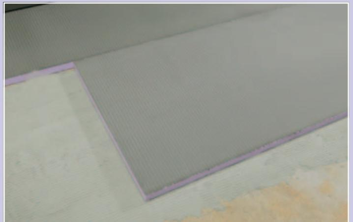
JACKOBOARD Plano wird in Höhe und Ebenheit mit der Was-serwaage ausgerichtet.
