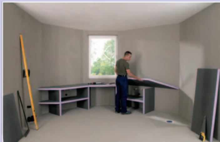
Die Waschtischplatte wird auf die Unterkonstruktion aufgeklebt. Vor dem Verfliesen werden alle Plattenstöße und sichtbaren Stirnkanten mit JACKOBOARD Armierband abgespachtelt.
