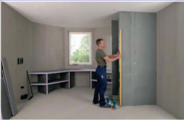
Die Duschtrennwand ist fertig. Vor dem Verfliesen müssen jetzt noch alle Bauplattenstöße im Außenbereich der Dusche mit JACKOBOARD Armierband abgespachtelt werden.
