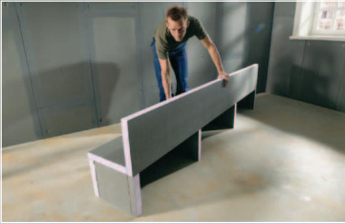
Für eine Badewannenverkleidung wird eine Tragkonstruktion aus JACKOBOARD Plano in 50 mm gefertigt und mit Montagekleber verklebt.
