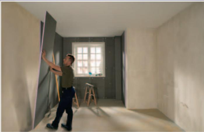
JACKOBOARD Plano wird schräg am Boden angesetzt, ange-drückt und mit der Wasserwaage ausgerichtet.
