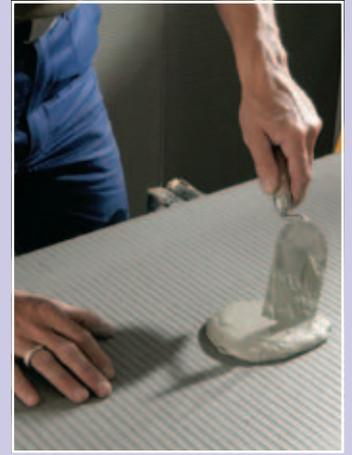
Bei dem Einsatz von JACKOBOARD Plano im Wandbereich werden mit einem Schraubenzieher 8 Löcher (5 pro m<sup>2</sup>) als Markierung durch die Bauplatte gestoßen. Auf diese Lochmarkierungen werden Mörtelbatzen aufgetragen.
