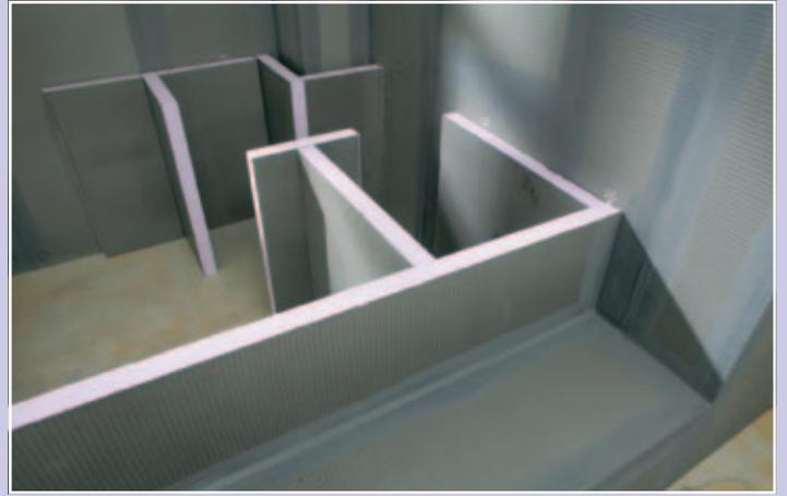
Im Abstand von ca. 40 cm werden zusätzlich Bauplattenstützwände mit Montagekleber an Wand und Boden fixiert.
