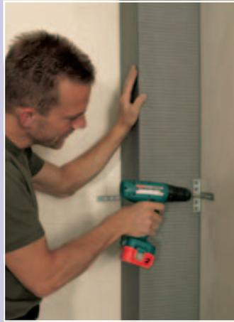
Das Winklelement JACKOBOARD Canto ermöglicht es Rohrleitungen schnell zu verkleiden und kann sowohl senkrecht als auch waagrecht eingesetzt werden.
