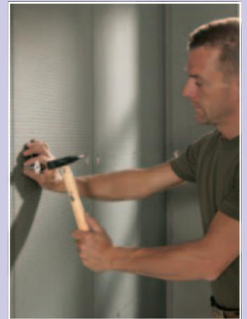
Nach Aushärtung der Mörtelbatzen werden die Dübel-löcher mit Hilfe einer Schlagbohrmaschine gebohrt und mit JACKOBOARD Metall-Dübeln fixiert. Als Bohrhilfe dient wie-der die Lochmarkierung.
