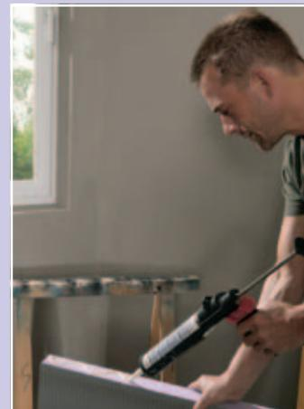
JACKOBOARD Plano wird ausgemessen und zugeschnitten. Montagekleber wird auf die Stirnkanten aufgetragen.
