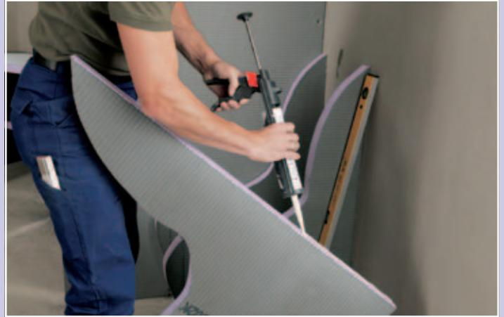
Die Bauplattenelemente werden im Abstand von ca. 40 cm mit Montagekleber an Wand und Boden angeklebt.
