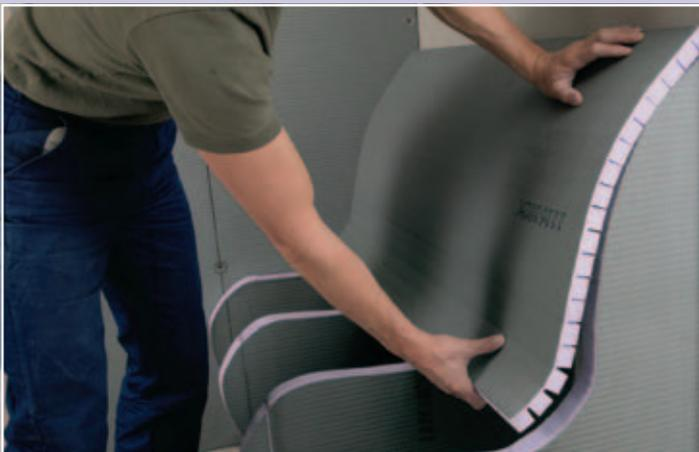
Durch die geschlitzte Oberfläche kann JACKOBOARD Flexo genau an die Unterkonstruktion angepasst werden. Hierbei wird die Kreativbauplatte mit der geschlitzten Seite nach unten aufgelegt und mit Montagekleber befestigt. Zur einfacheren Montage kann die Kreativbauplatte zusätzlich mit Holzschrauben punktuweise fixiert werden. Alle Stoßkanten und sichtbaren Stirnkanten müssen jetzt mit JACKOBOARD Armierband bzw. Dichtband verspachtelt werden.
