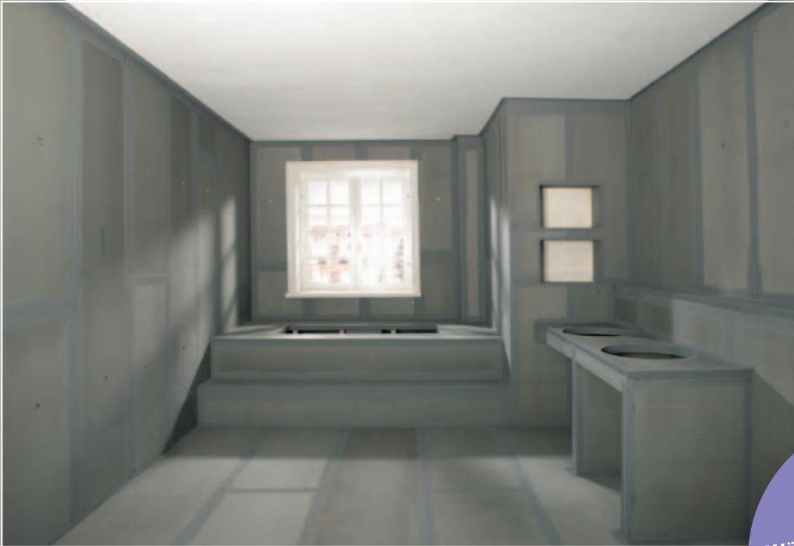
Nachdem alle Stoßkanten mit JACKOBOARD Armierband oder Dichtband abgespachtelt wurden, kann das Bad direkt verfliest, verputzt oder verspachtelt werden.
