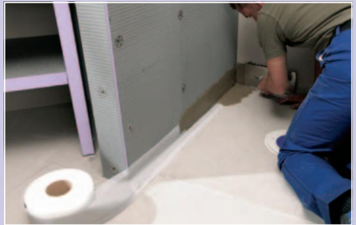
Um ein Hinterlaufen mit Wasser zu verhindern, werden im Nassbereich der Dusche alle Fugen und Übergänge mit dem JACKOBOARD Dichtband abgedichtet.
