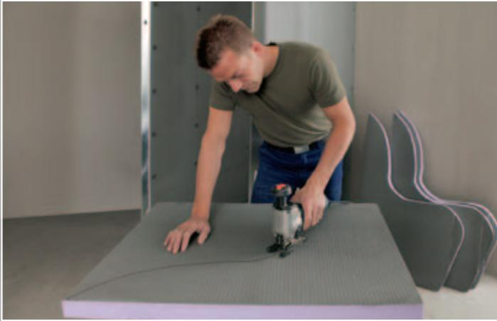
Die Unterkonstruktion der Sitzbank aus 50 mm JACKOBOARD Plano wird mit einer Stichsäge ausgesägt.
