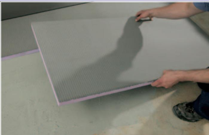
Im Bodenbereich zur Entkopplung von Rissen und als zusätz-liche Wärmedämmung wird die Bauplatte durch leichtes Hin- und Herschieben in den Fliesenkleber eingebettet
