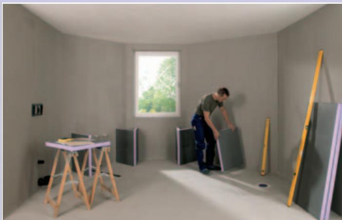
Als Unterkonstruktion für den Waschtisch werden die Bauplatten-Elemente an Wand und Boden angeklebt.
