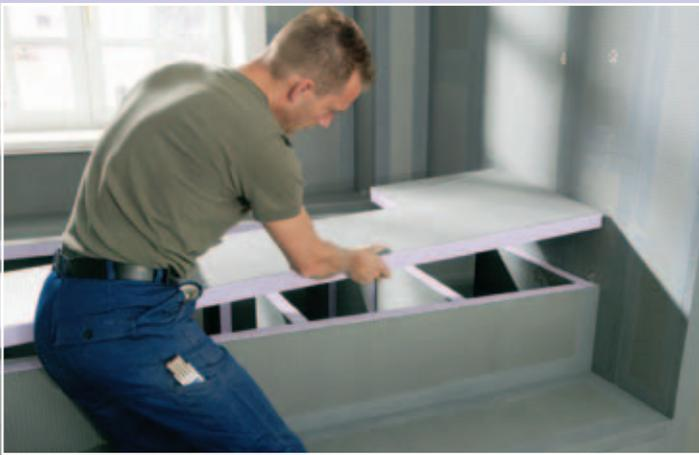
JACKOBOARD Plano wird ausgeschnitten und als Abdeckung auf die Tragkonstruktion mit Montagekleber aufgeklebt.
