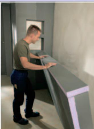
Nach Vermessung und Zuschnitt werden die einzelnen Bauplatten mit Montagekleber fixiert. Zur Stabilisierung können zusätzlich noch einzelne Bauplatten-Rippen eingeklebt werden. Die konstruierte Nische mit Regalen sowie die Ablagenkonstruktion wird mit Montagekleber an Wand und Boden angeklebt.
