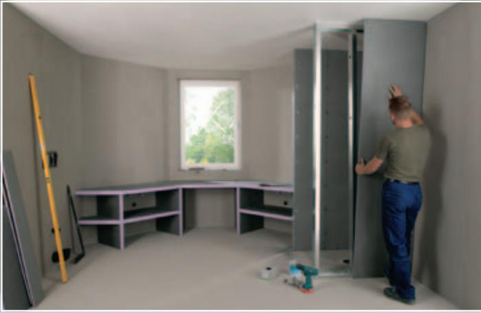
Das Duschelement JACKOBOARD Aqua ist bereits ebenerdig mit dem Estrich eingebaut. Das Metall-Ständerwerk bildet die Unterkonstruktion, die Bauplatten JACKOBOARD Plano werden passend auf Länge zugeschnitten.
