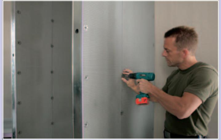
JACKOBOARD Plano wird mit geeigneten Blechschrauben (5 pro m<sup>2</sup>) unter Verwendung von JACKOBOARD Dämmplatten-Tellern fixiert.
